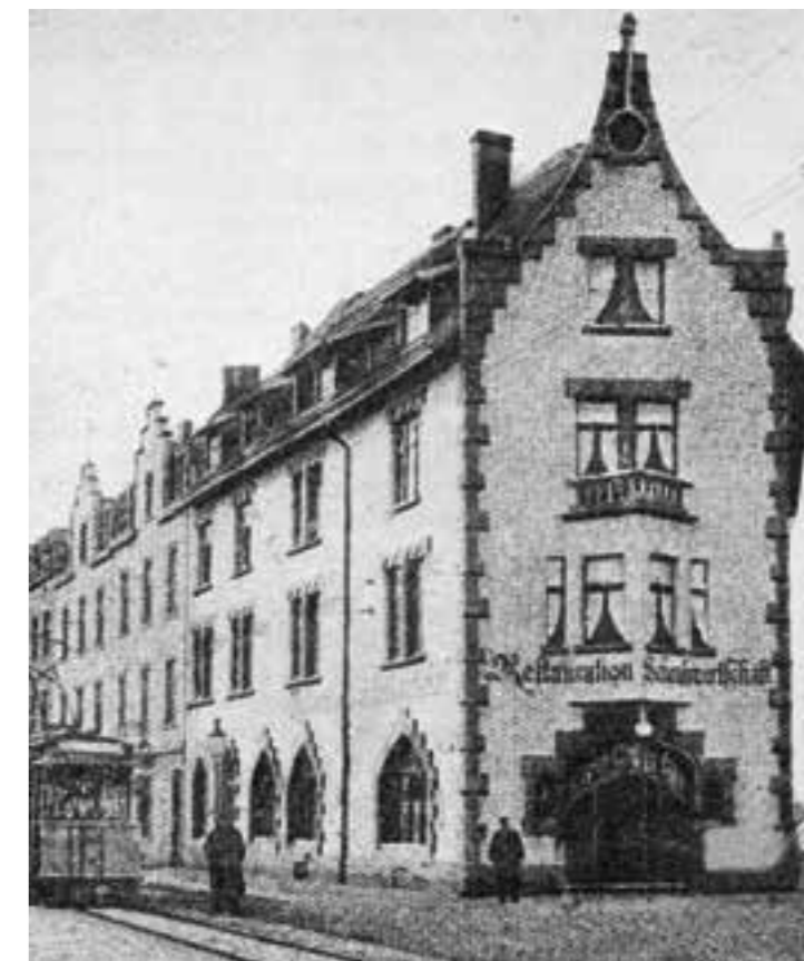
Der „Etteltblock“ Ecke Höninger Weg / Kalscheurer Weg um 1905, links die alte Straßenbahn
