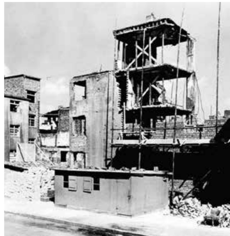
Wiederaufbau des Wohnhauses Zollstockgürtel / Alfterstraße: noch irgendwelche Fragen zu Statik und Bauaufsicht?
