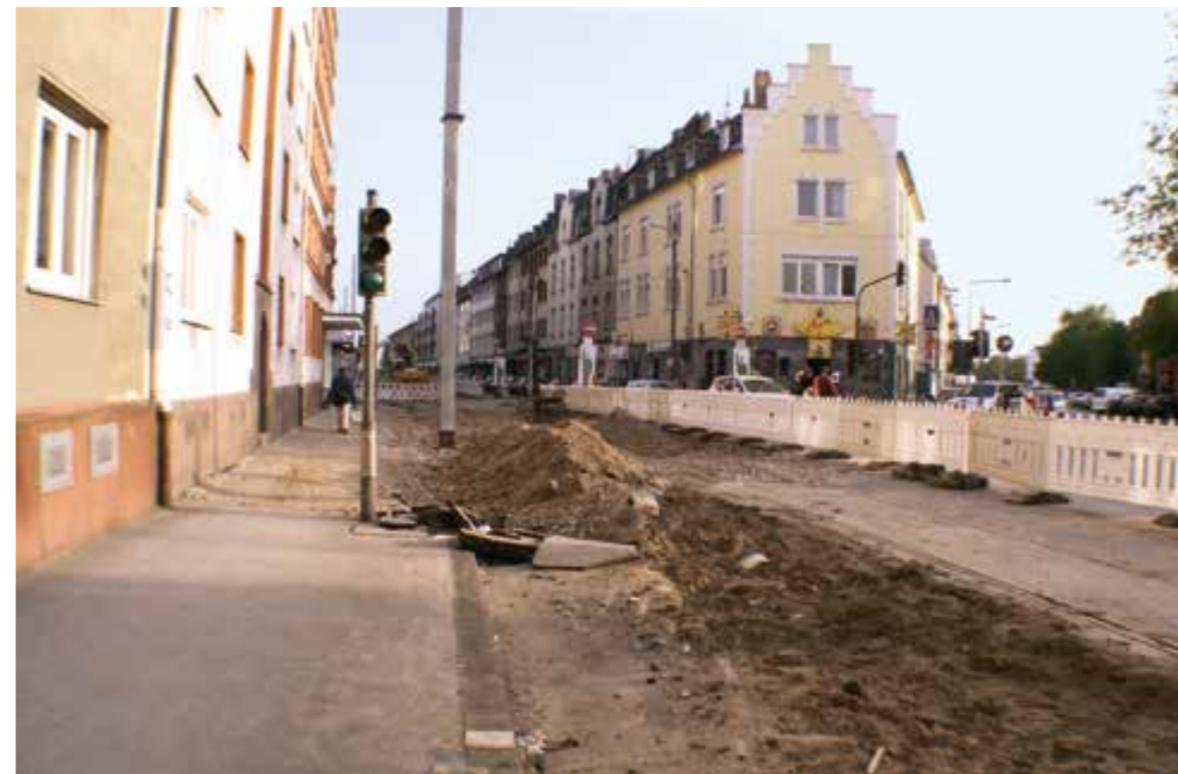
... derselbe Ort 2007, beim Bau der neuen KVB-Gleisanlagen
